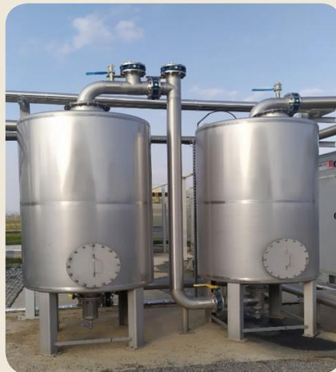
Figure 7 : Schéma et exemple d'un filtre de charbon actif
