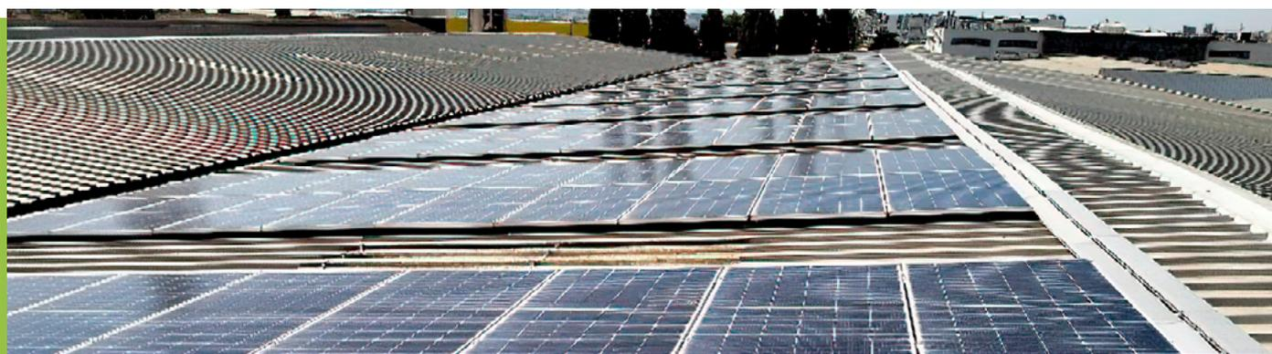
Le projet du Comptoir National Tunisien consiste à **équiper les locaux de la société à Tunis-Charguia et à Sfax par des installations solaires photovoltaïques destinées à l'autoproduction d'électricité**, raccordées au réseau électrique Basse Tension de la STEG.
